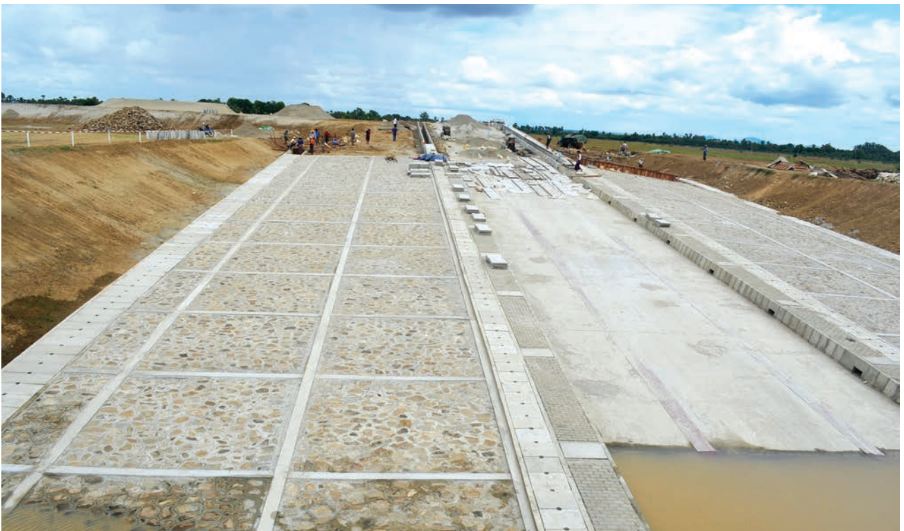
ဆီမီးနိုဧရာဝတီဆိပ်ကမ်းတွင် ကုန်တင်/ကုန်ချ RAMP လမ်းကြောင်းတည်ဆောက်မှုအားတွေ့မြင်ရပုံ
