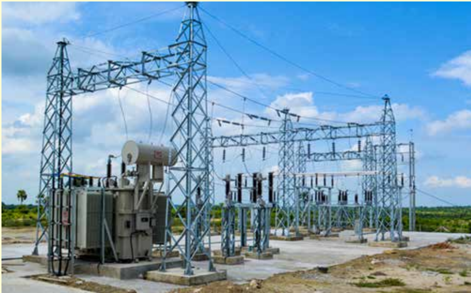
66/11 KV 20 MVA Sub-Station ဓာတ်အားခွဲရုံ
